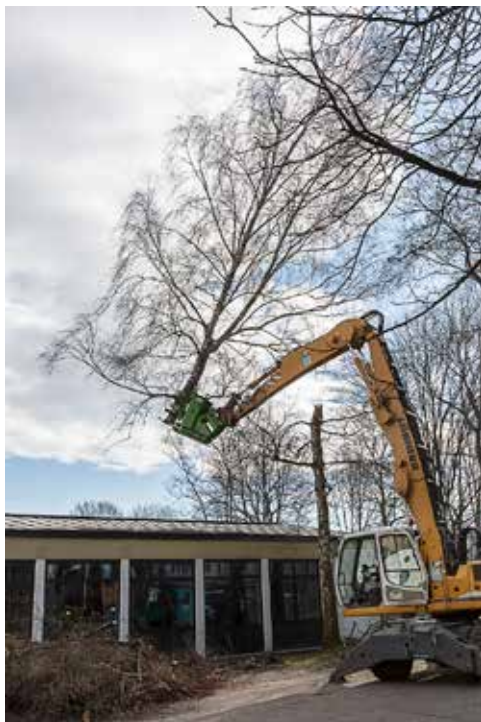
Der Startschuss zu den Bauarbeiten fiel am 31. Januar 2018 mit der Rodung von Bäumen und Sträuchern, die der Baustelle im Weg waren. (Aufn.: kb)
