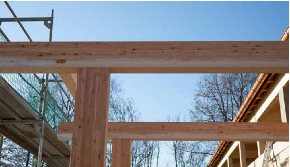
Oben: 27. Februar 2019 Die Balkenkonstruktion für den neuen Zugangsbereich wird errichtet. Unten: 27. Februar 2019 Eine hochwertige Zimmermannsarbeit.
