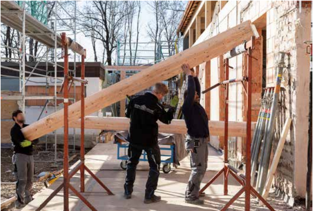
Oben: 27. Februar 2019 Die Balkenkonstruktion für den neuen Zugangsbereich wird errichtet. Unten: 27. Februar 2019 Eine hochwertige Zimmermannsarbeit.
