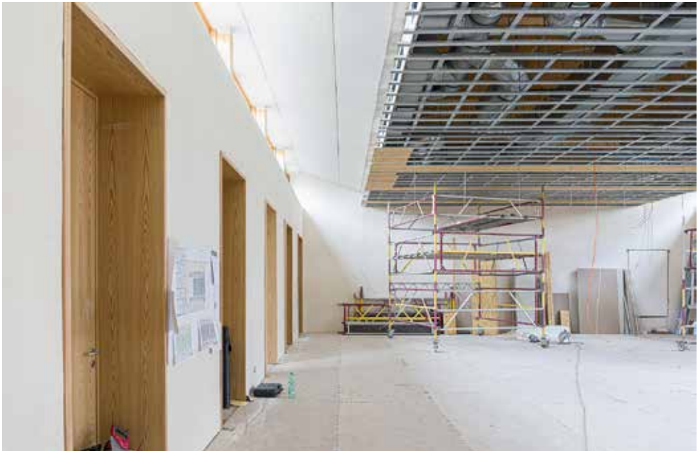
Oben: 20. Januar 2020 Links geht es zu den neuen Toilettenanlagen im Keller. Unten: 6. März 2020 Es fehlen nur noch die schallschluckenden Platten an der Decke (Fotos: kb)
