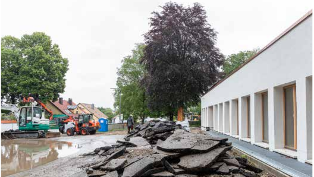
15. Juni 2020 Viele Quadratmeter Teerdecke müssen entfernt werden (Foto: kb)
