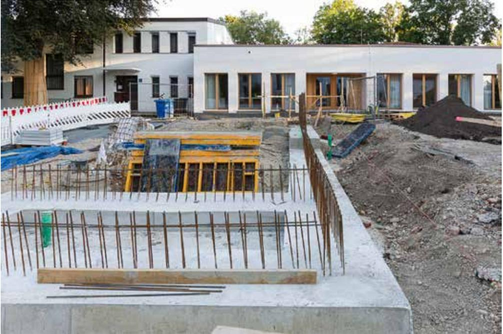
Oben: 21. August 2020 Fundamente für eine Betonmauer entlang des Eingangs und den Müllkastenbereich; unten: 21. August 2020 Auf der Westseite grünt es schon.
