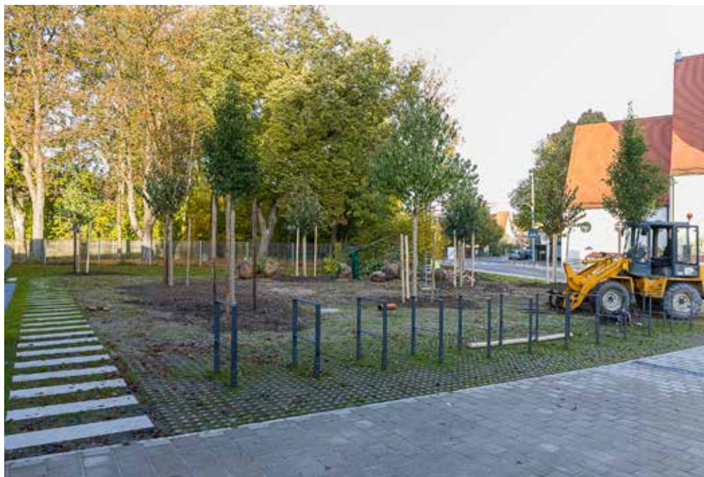
Oben: 20. Oktober 2020 Baumpflanzaktion auf dem ehemaligen Parkplatz
