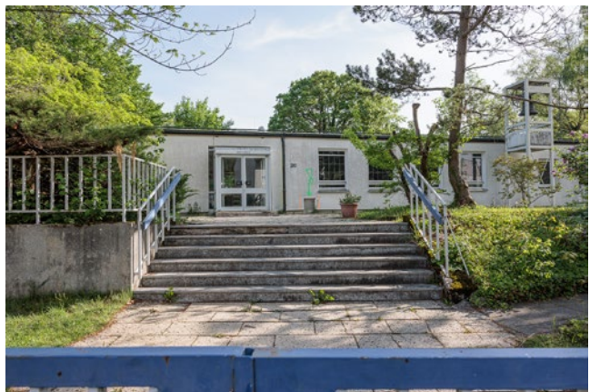
Das Gemeindezentrum Bartimäus vor dem Abriss im Mai 2022 (Foto: kb)
